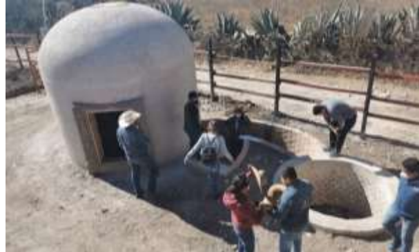
Zona de hornos: único con 2 tipos diferentes: mamposteado elevado y pozo.
