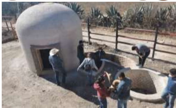
Zona de hornos: único con 2 tipos diferentes: mamposteo elevado y pozo.
